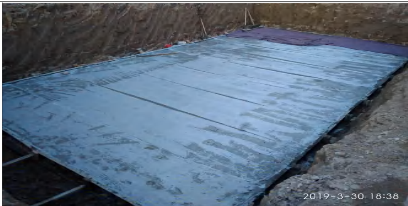
图 3-5 污水处理设施地面防渗处理
