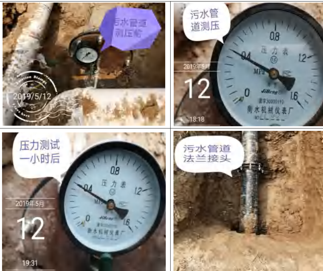
图 3-6 管道压力测试
